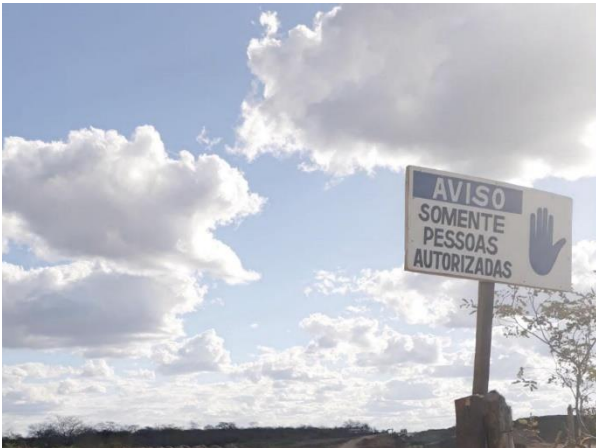
Figura 1: Trecho das obras da transposição do rio São Francisco. Arquivo do Programa TransVERgente.
